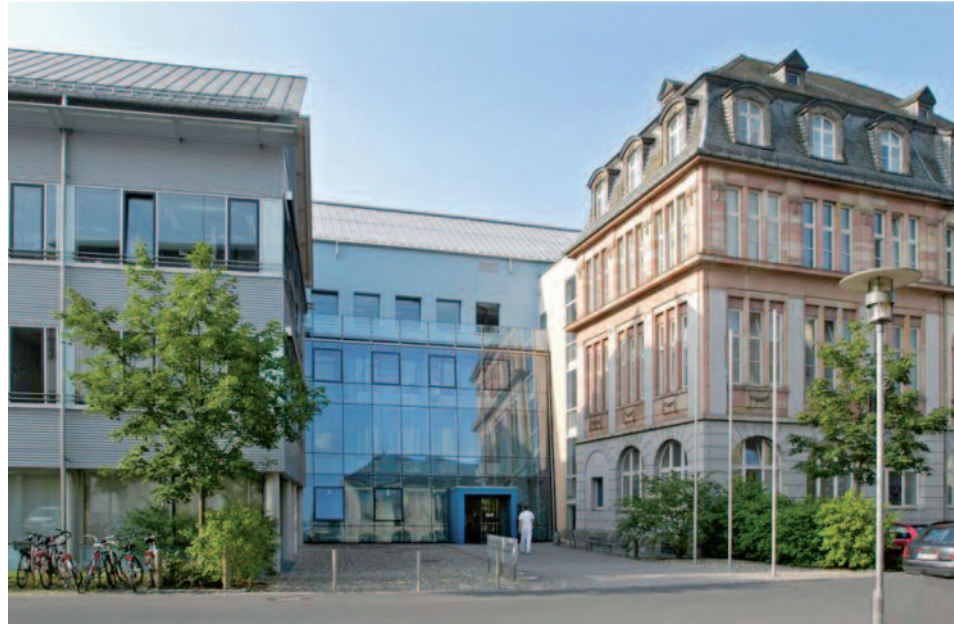
Die Architektur der Zahnklinik Würzburg verbindet Tradition und Moderne.
