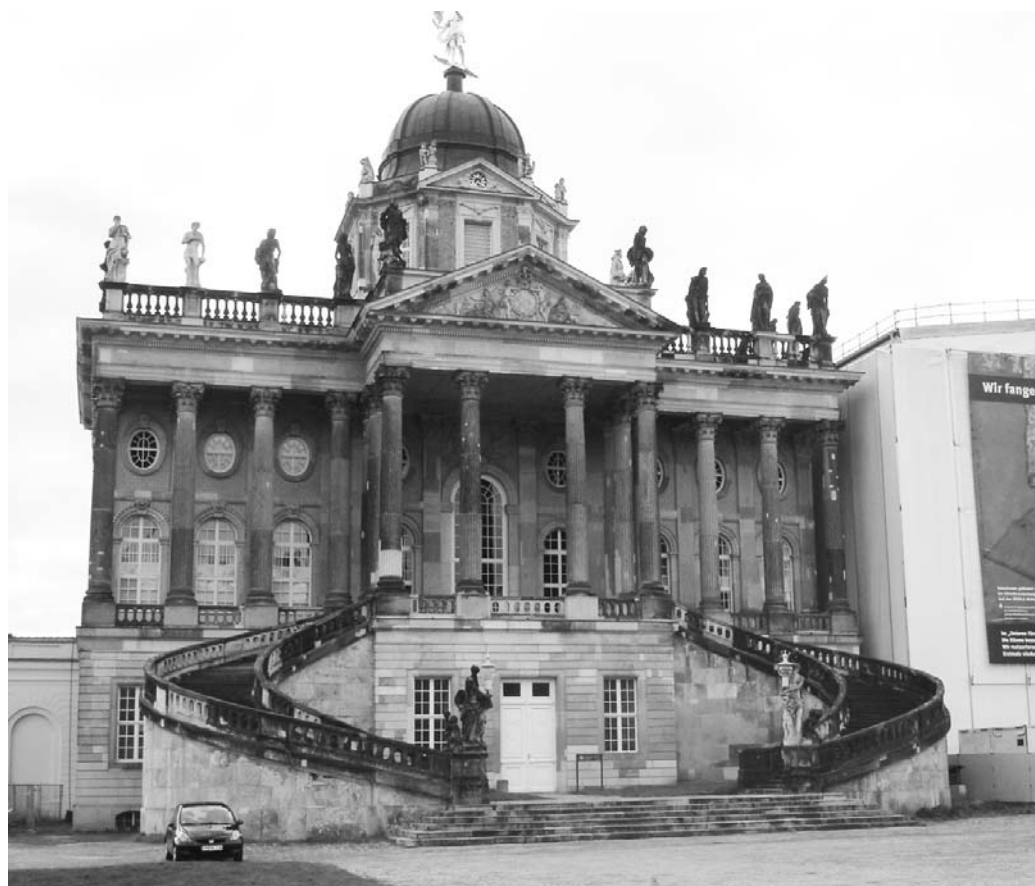
Wirtschaftsgebäude für das Neue Palais.
